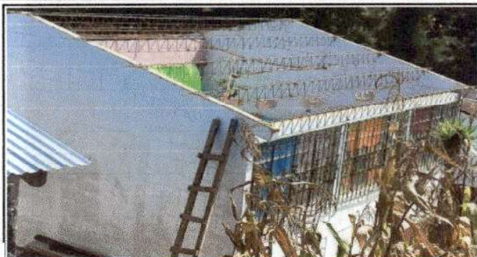
Foto 1: Sustrucción de lámina, por lámina troquelada en mudulo 3 de aulas.
