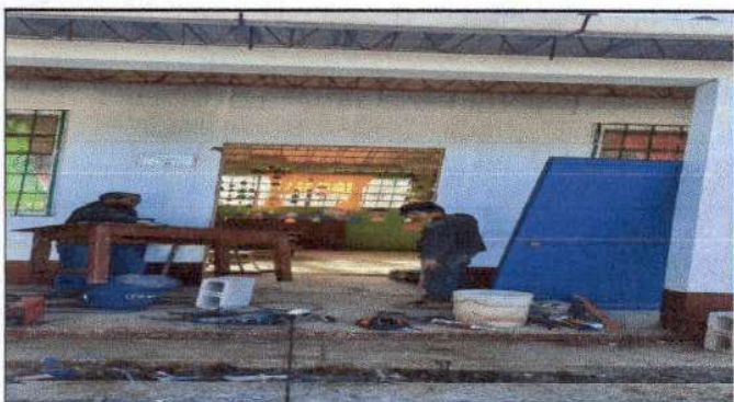
Foto 4: Sustrucción de puerta en modulo 3 de aulas.
