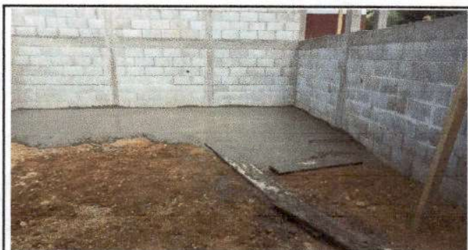
Foto 6: sustitución de piso líquido de cemento en mpdulo 2 de cocina.
