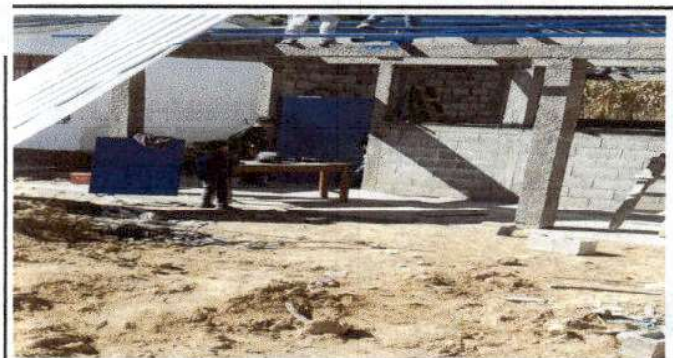
Foto 5: Sustrucción de puerta en modulo 2 de cocina.
