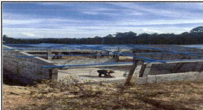
Foto 2: Sustrucción de estructura de soporte de metal, por metal en modulo 2 de cocina.
