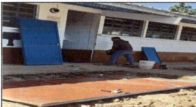
Foto 3: Sustrucción de puertas en modulo 1 de aulas.
